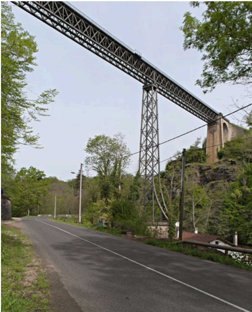
Vue du viaduc en contre-plongée depuis la route.
