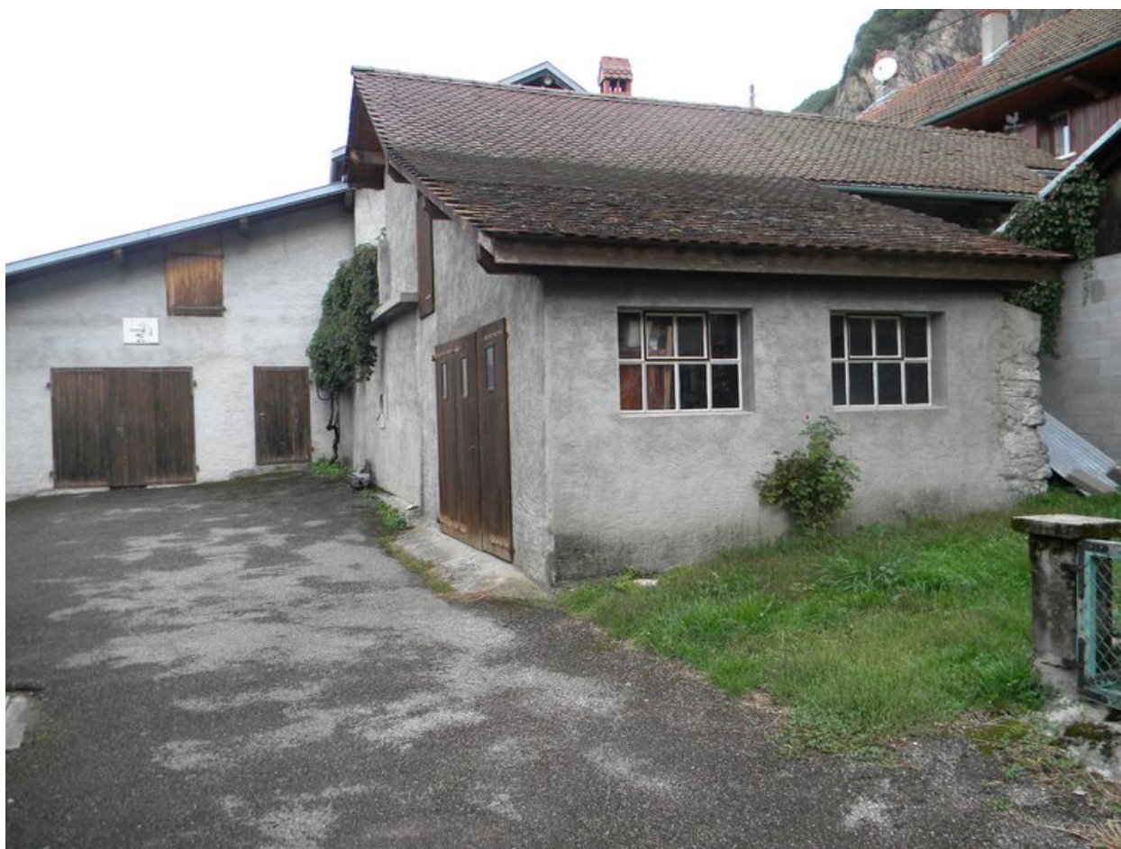
Vue d'un hangar aménagé sur du bâti ancien (2008 B4 500,501).
