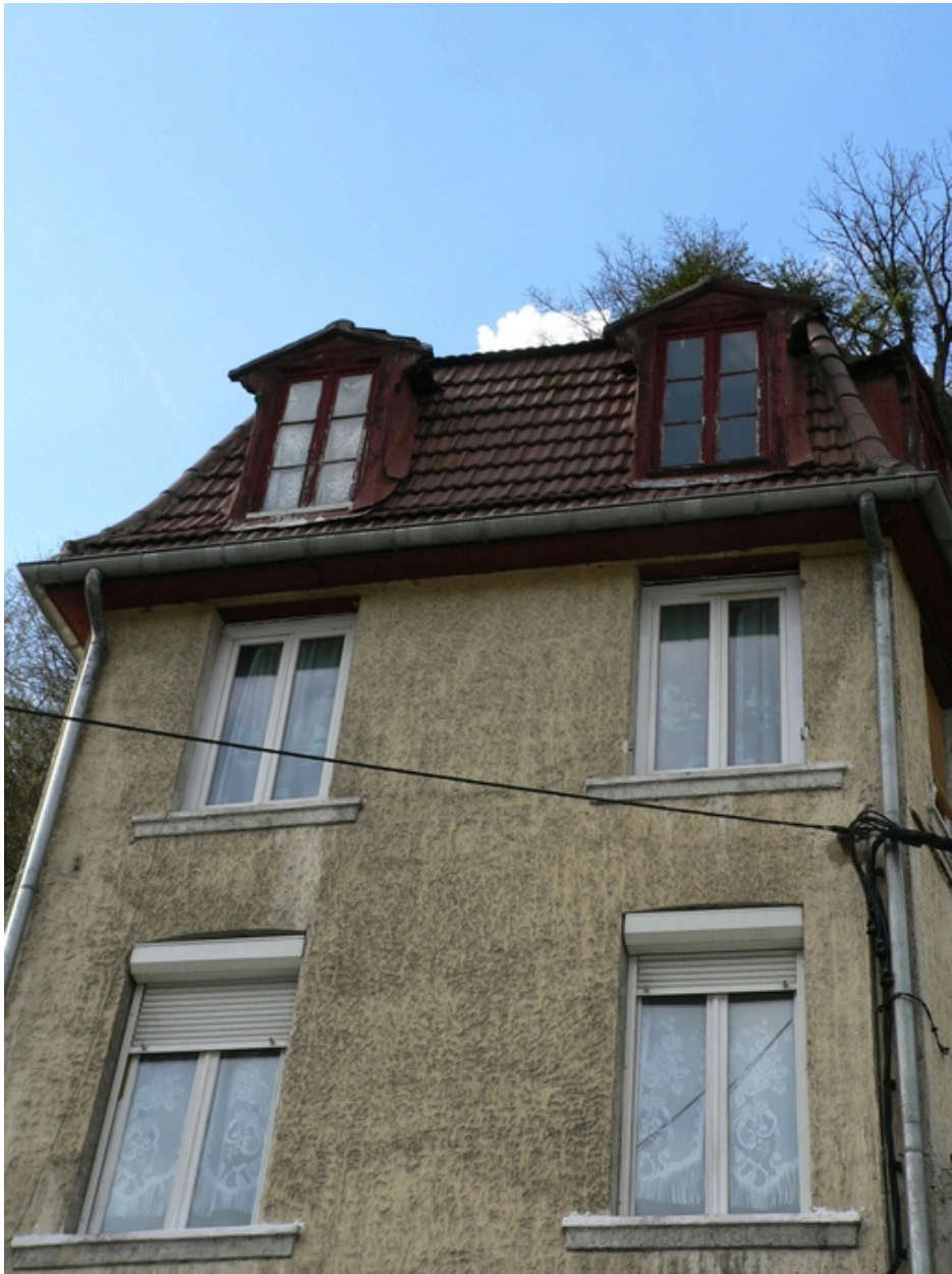
Lucarnes à fronton pignon
