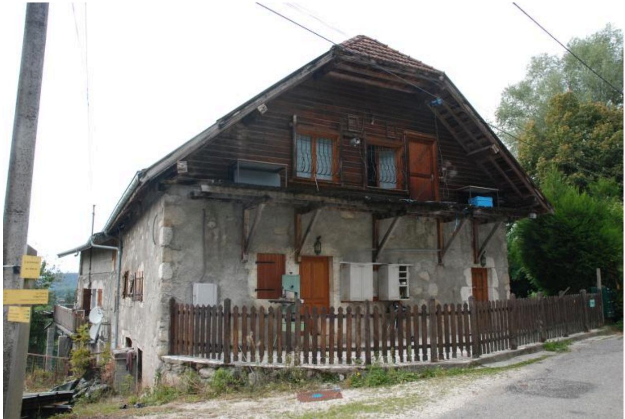
2015 A4 1436, Lacrevez, ferme. Vue d'ensemble depuis la route.
