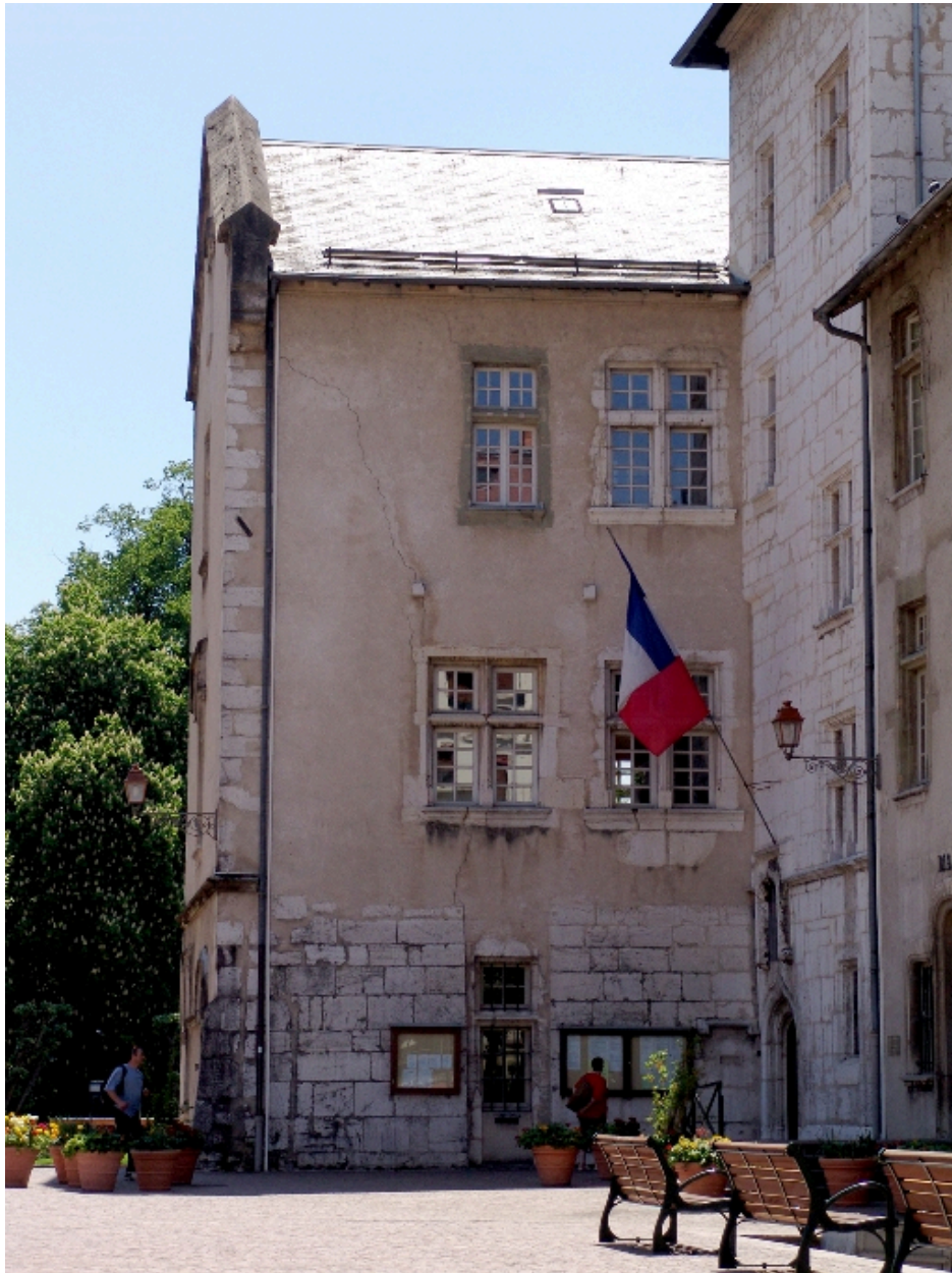
Façade nord de l'aile sud
