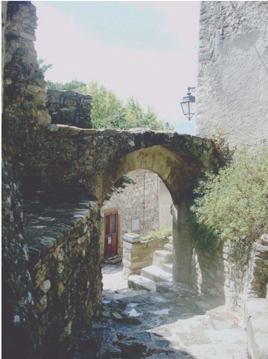
Porte sud-ouest, vue de l'intérieur du castrum.
