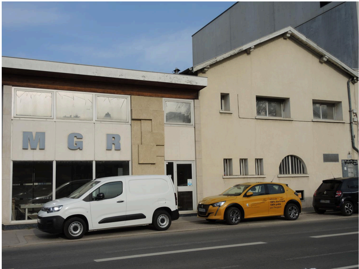
Vue est du site
