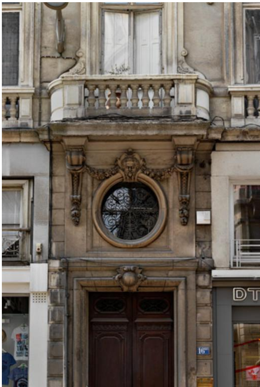
16 bis rue Gasparin : partie supérieure de l'entrée, oculus de l'entresol et balcon axial du premier étage carré
