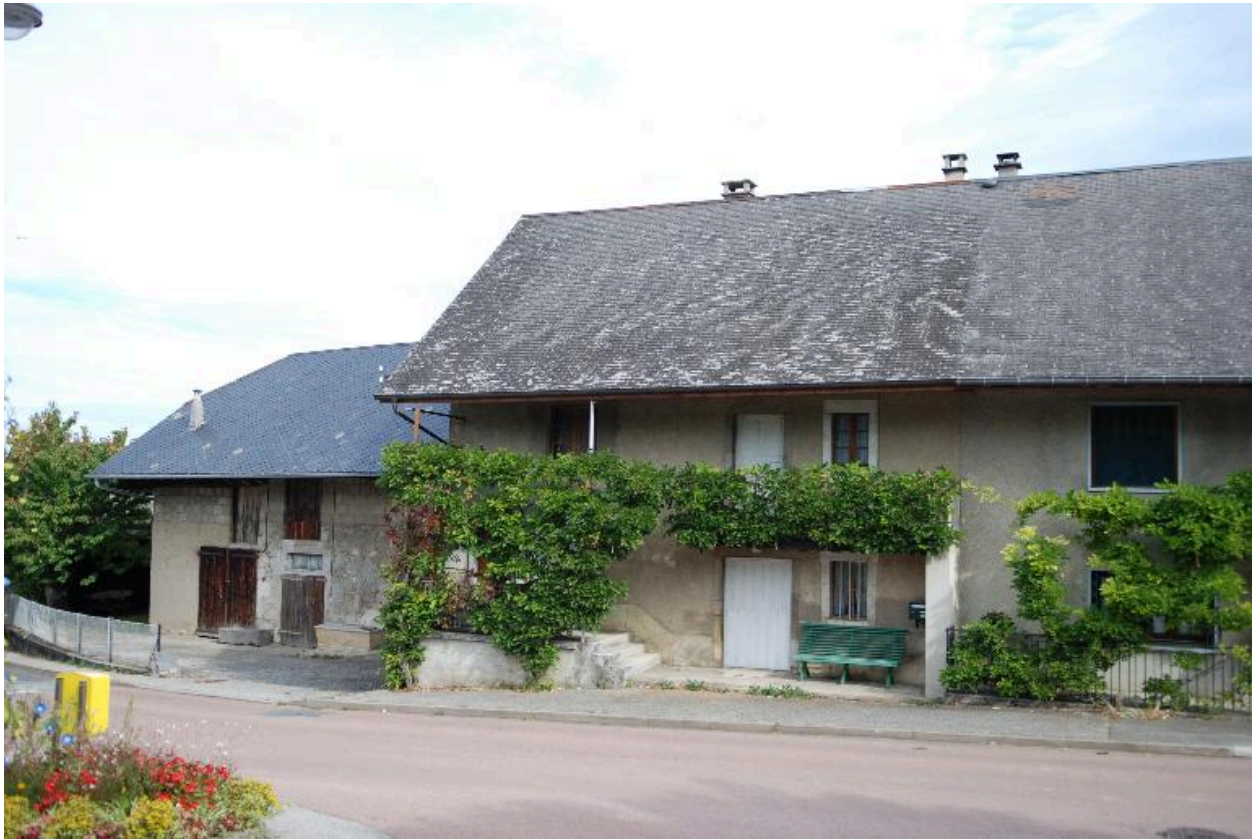
Vue d'ensemble d'une ferme à Trévignin (2014 B4 336), non repérée : partie habitation.
