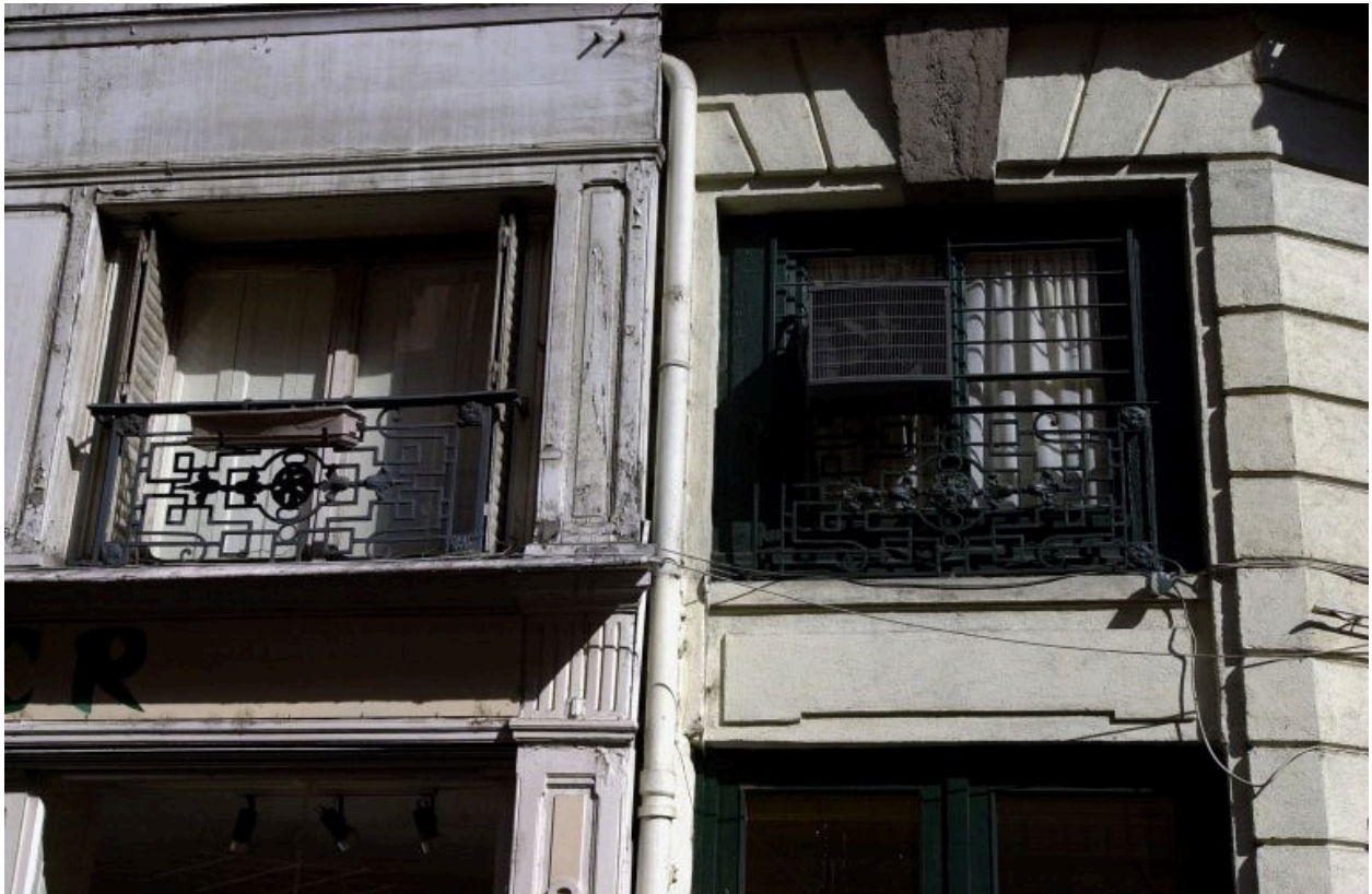
Façade rue Chavanne, fenêtre de l'entresol et ferronnerie
