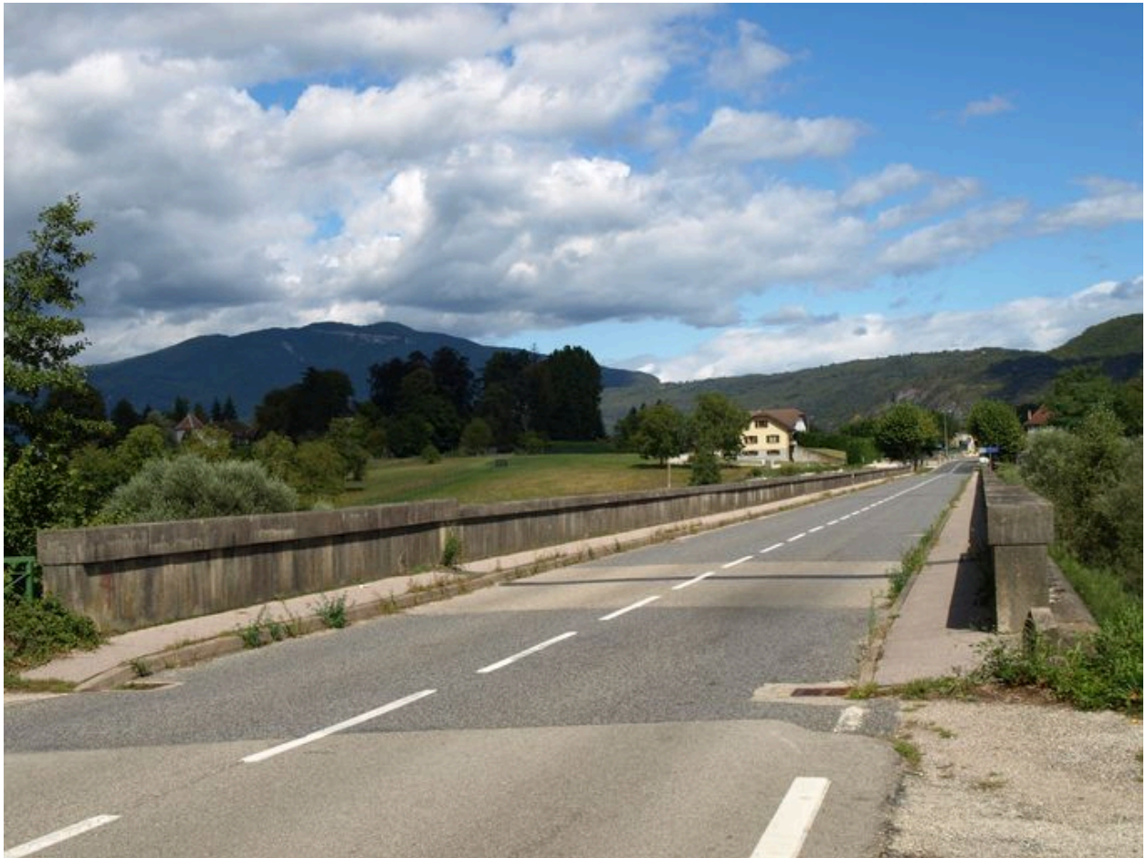
Chaussée (depuis la rive gauche)
