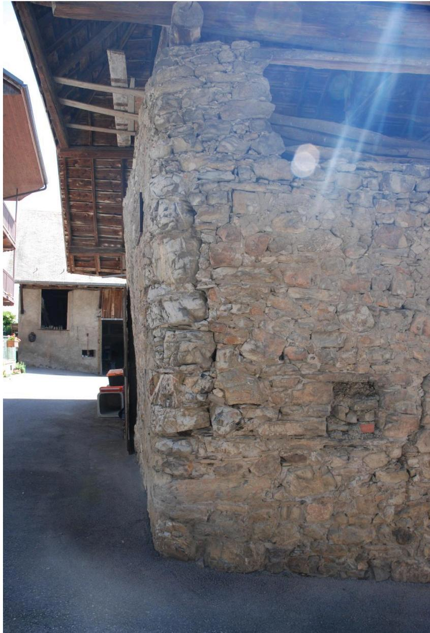
Cuvage (2018 C2 314). Détail de mise en oeuvre de l'angle arrondi.
