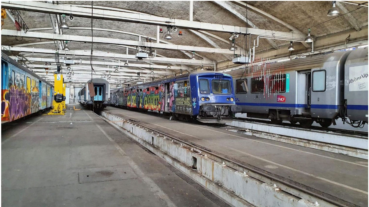
Vue d'ensemble intérieur de la halle
