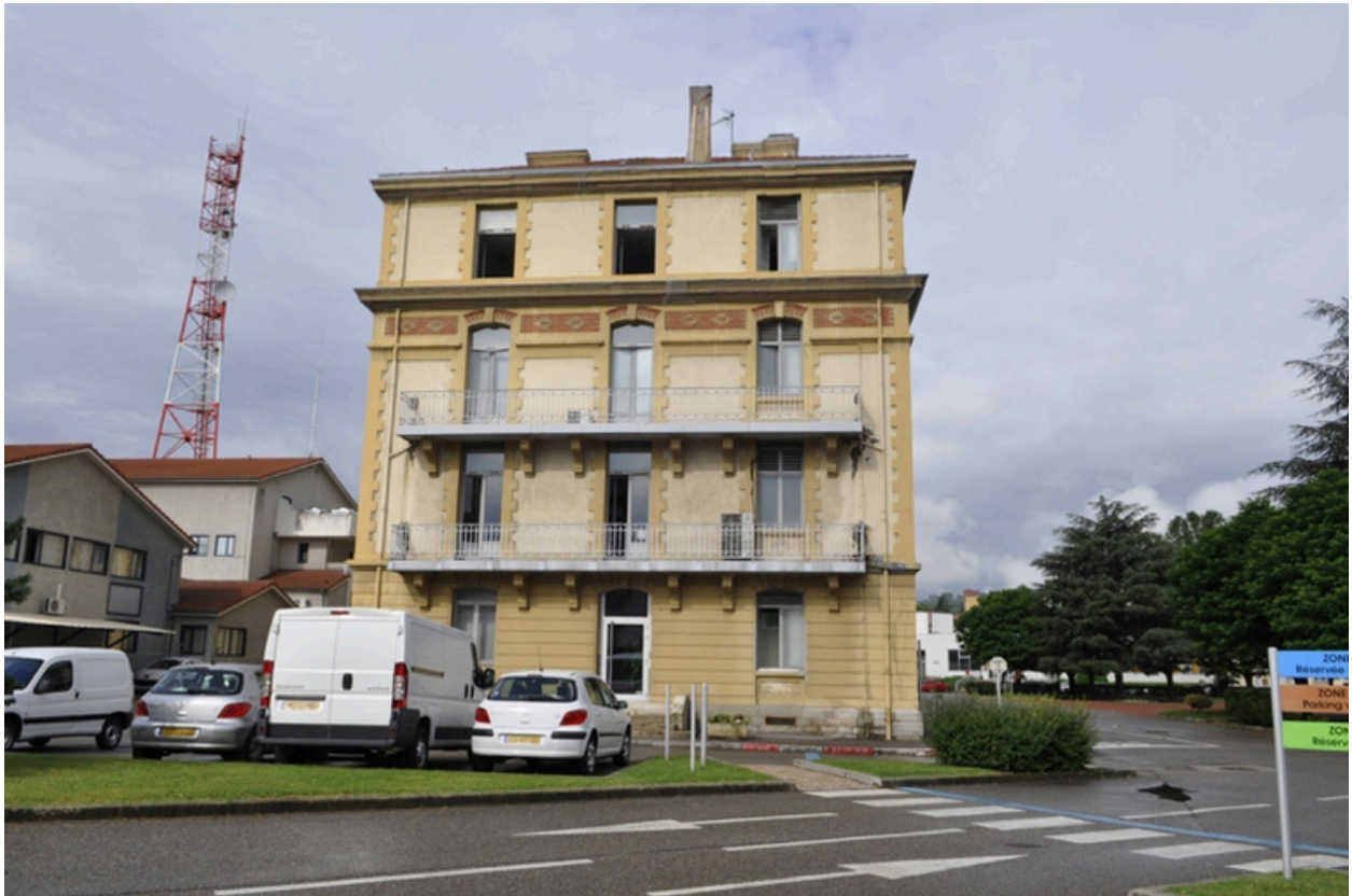
Bâtiment de 1916, vue du pignon est.
