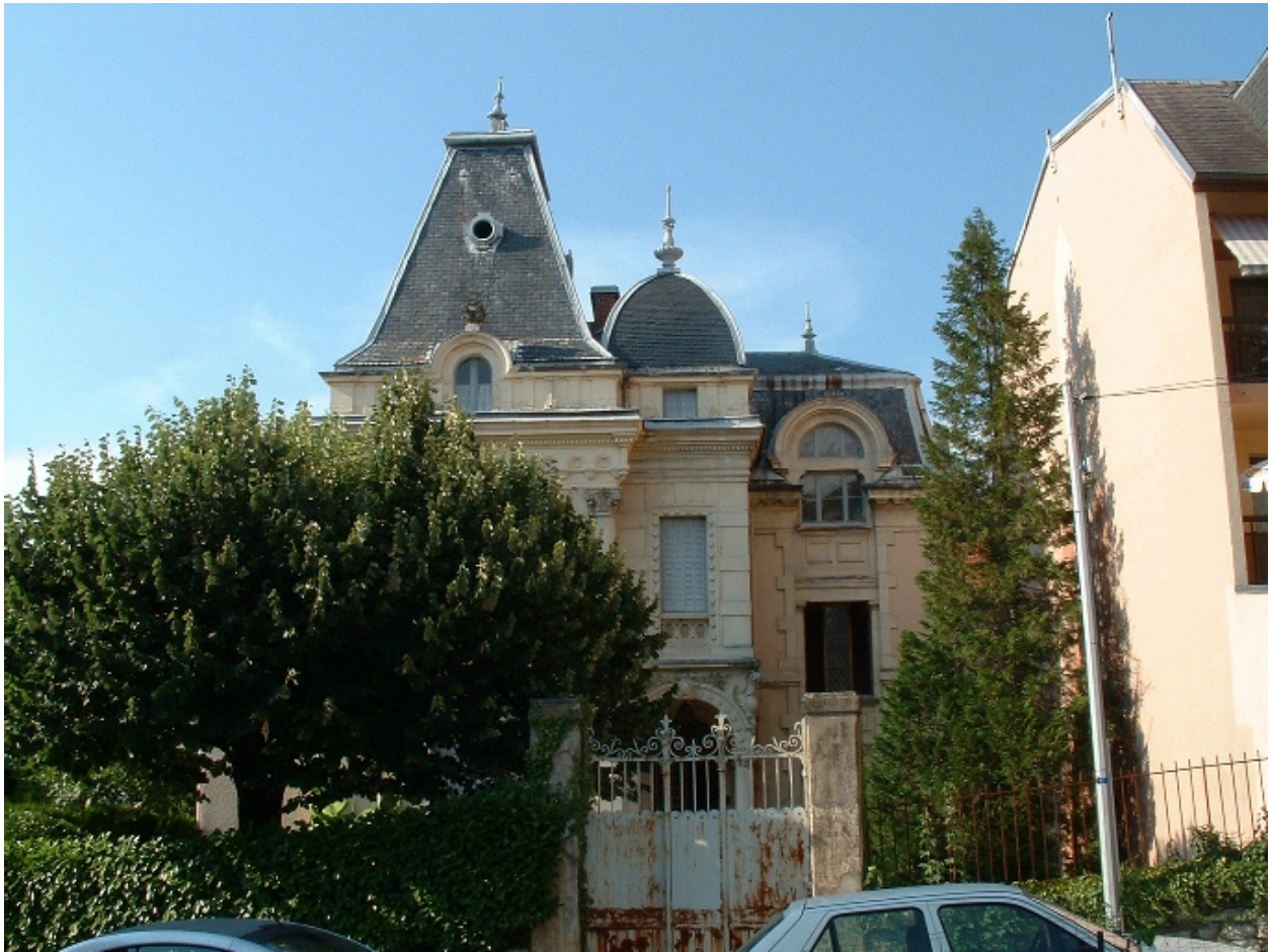
Façade depuis la rue
