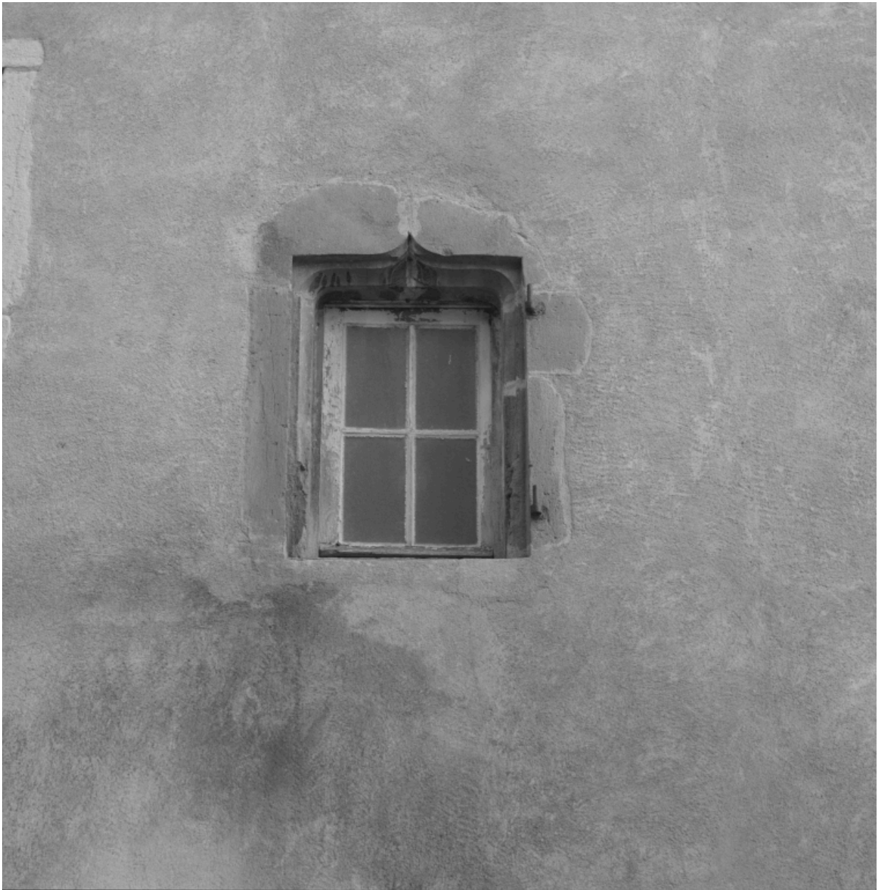
Élévation sur rue du Port : fenêtre au 1 e étage.
