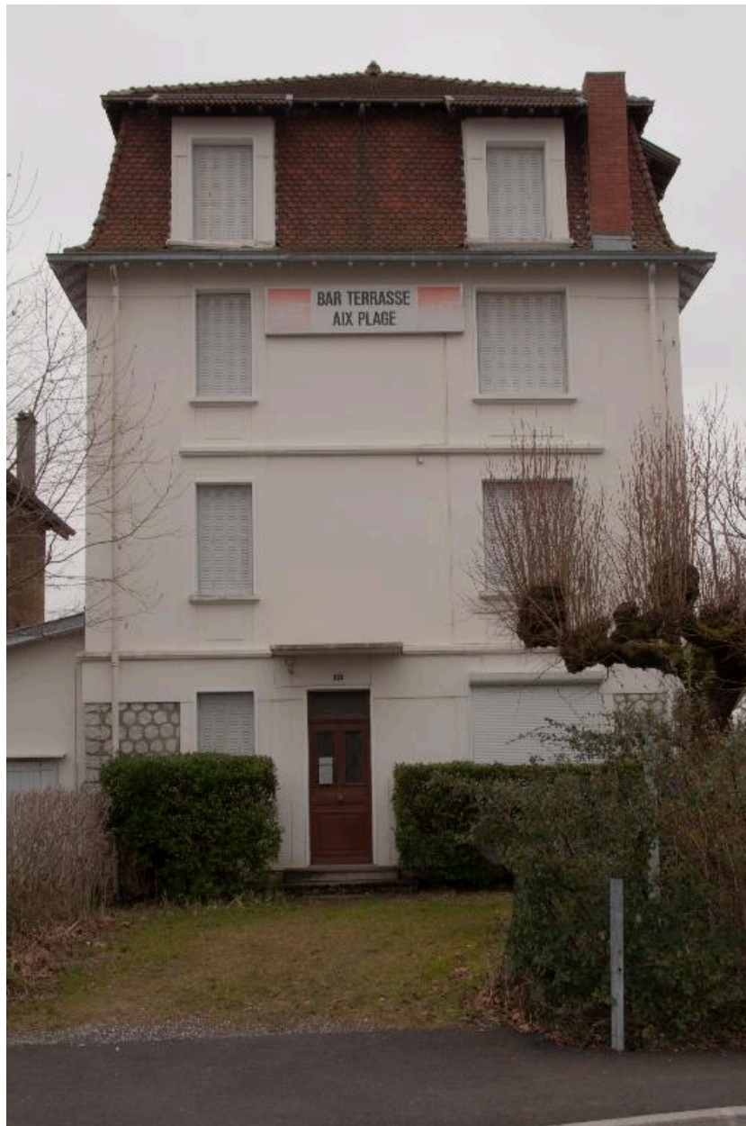
Immeuble Besson : façade nord
