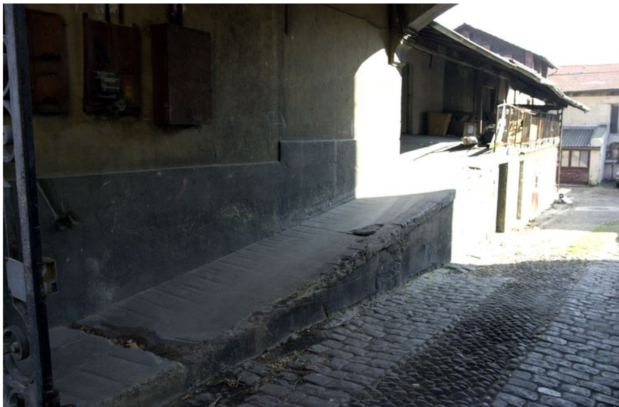
Passage cocher et rampe
