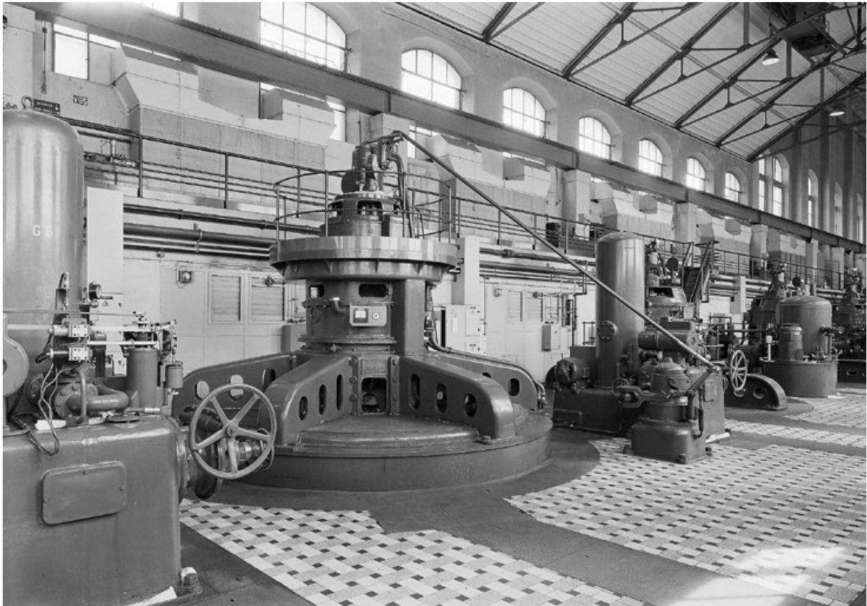
Turbine G5, constructeur : Théodore Bell et Cie
