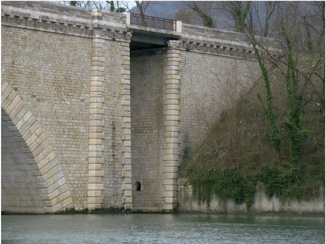
Vue de la culée et coupure rive droite, face amont
