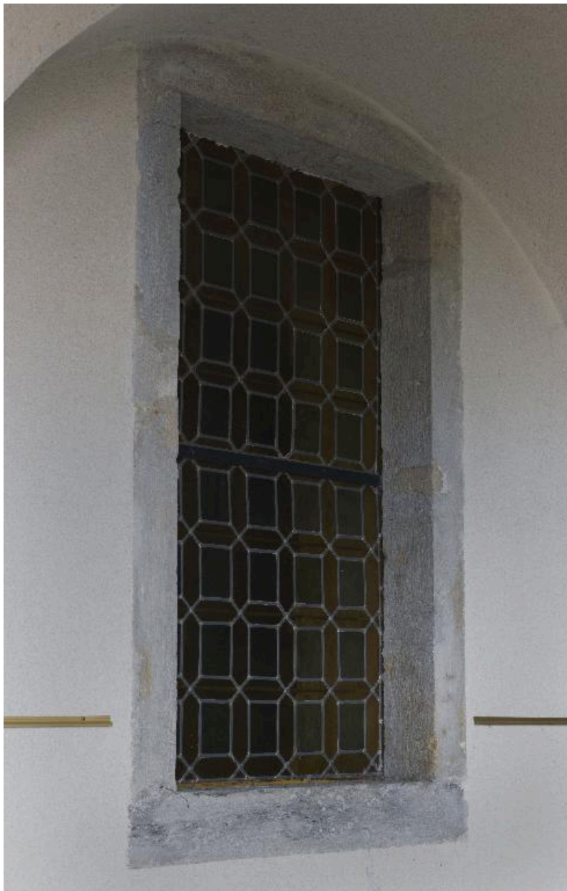
Vue d'une fenêtre, dans la galerie sud du cloître
