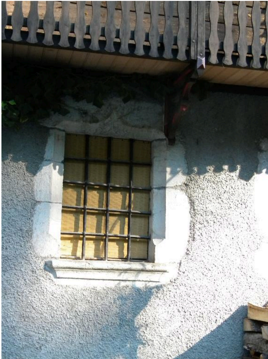
détail d'une fenêtre à accolade et tablette moulurée sur une ancienne ferme (2008 D4 2737, 2738).
