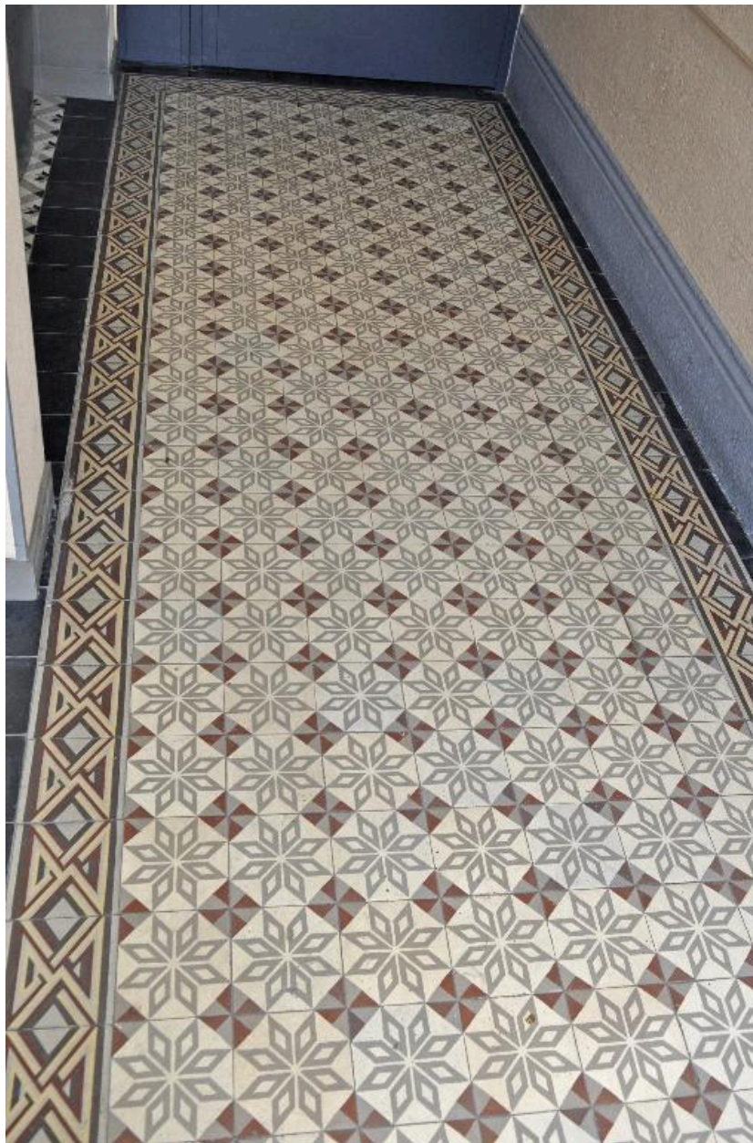
Vue intérieure : pavement de l'allée
