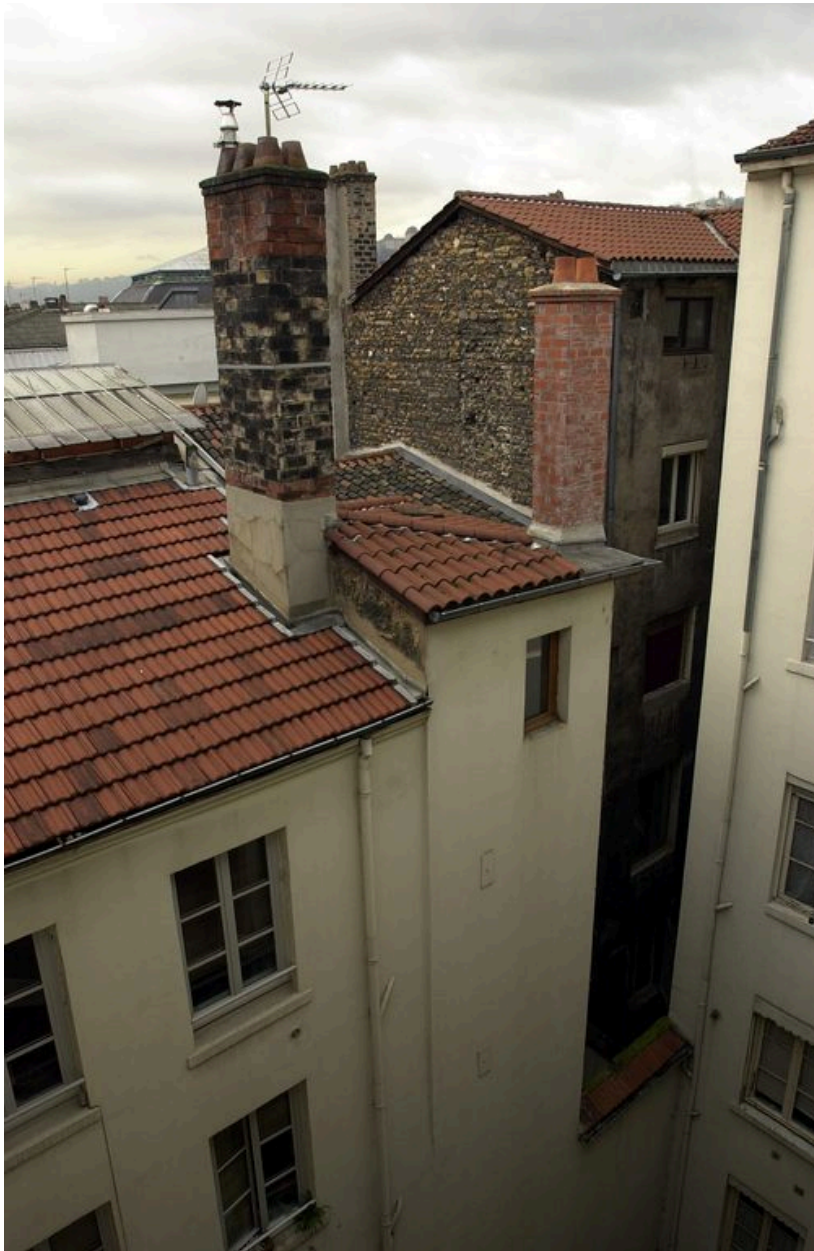
Elévation nord de la cage d'escalier depuis le 8 rue de l'Ancienne-Préfecture
