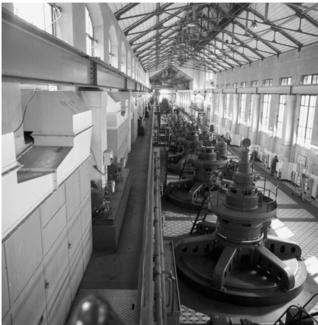
Vue d'ensemble sud-ouest
