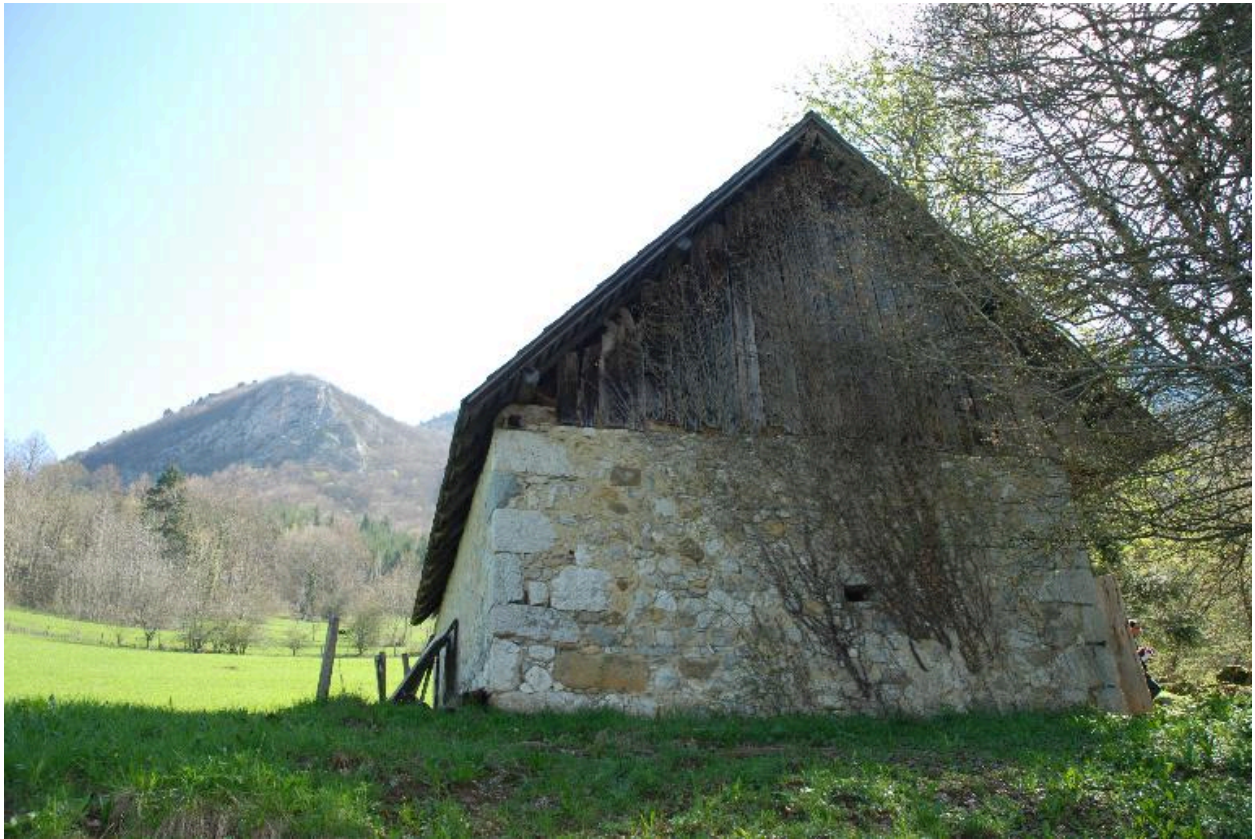
Vue du mur pignon ouest.
