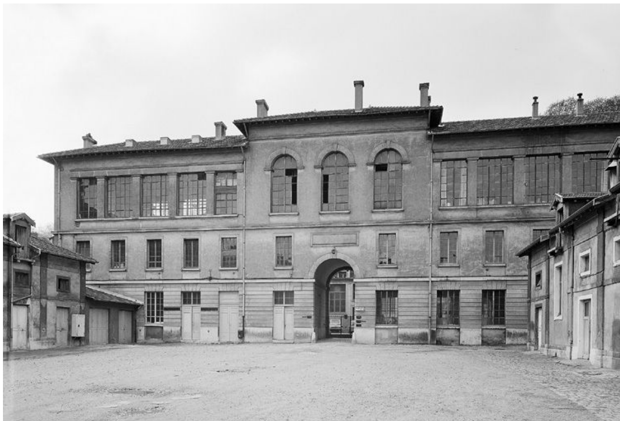
Bâtiment de médecine générale, façade antérieure sur la cour des Hôpitaux
