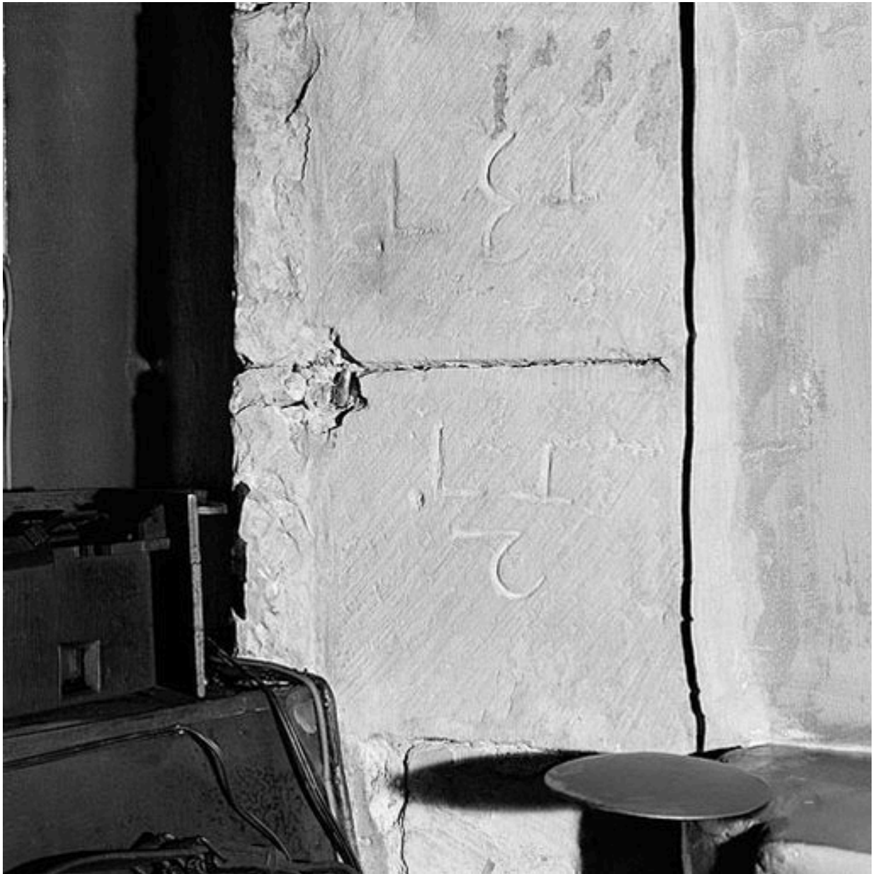
Marques de tâcheron (et de pose ?) au rez-de-chaussée (restaurant Le Village)
