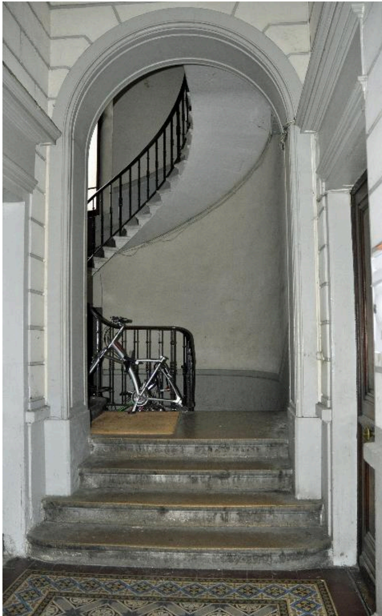
Vue intérieure : emmarchement au départ de l'escalier
