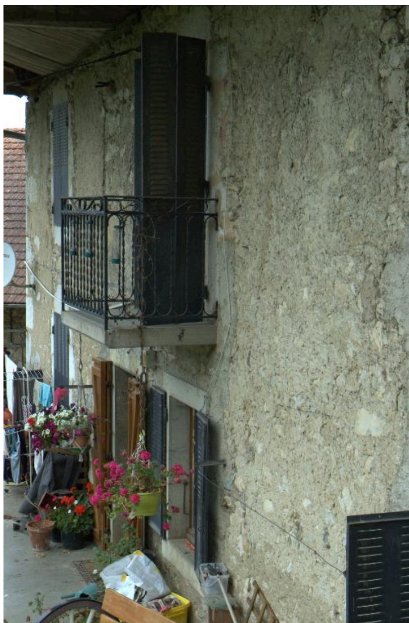
Détail du balcon situé sur la façade principale de la ferme d'habitation.
