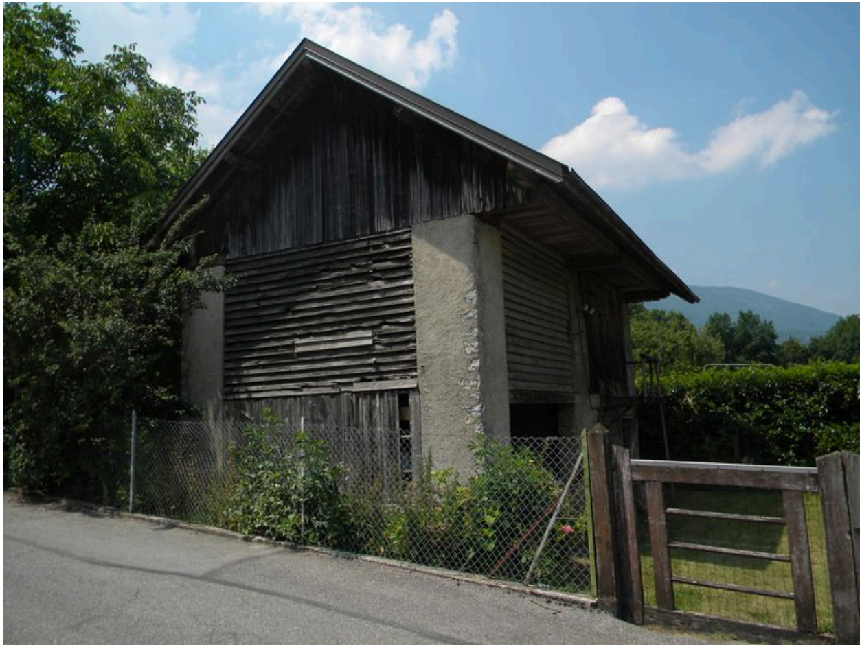
Vue du pignon sud de la grange.
