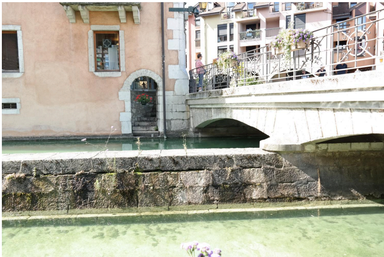
Pont de la République, détail du mur du canal de dérivation
