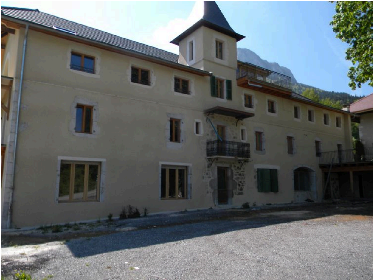
Vue de la façade nord avec la tourelle centrale.
