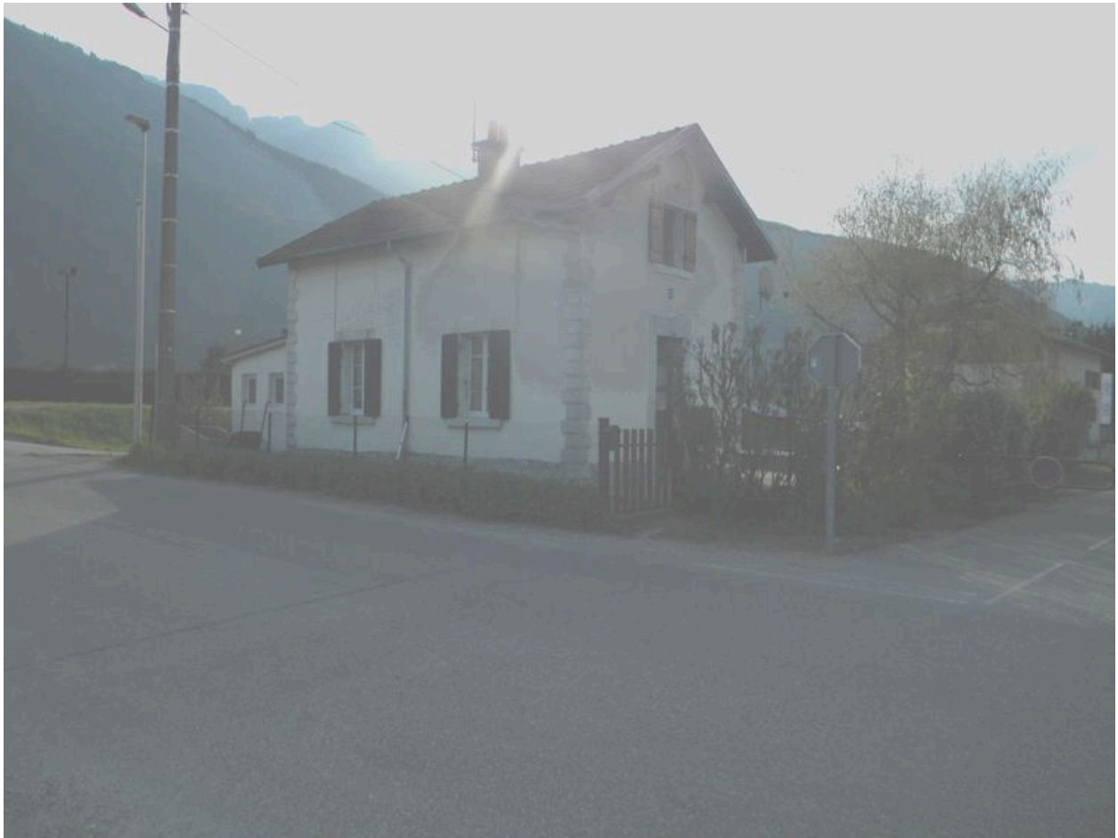
Vue de la façade ouest.
