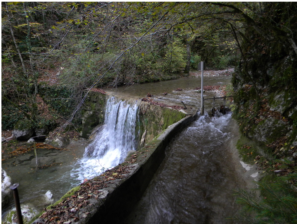
Vue du barrage et de la prise d'eau.
