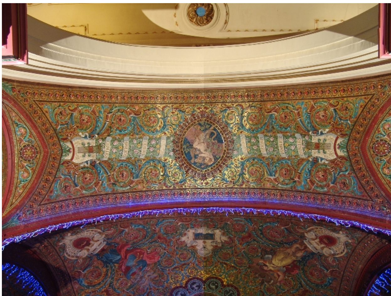
hall sud : arc doubleau de la coupole centrale
