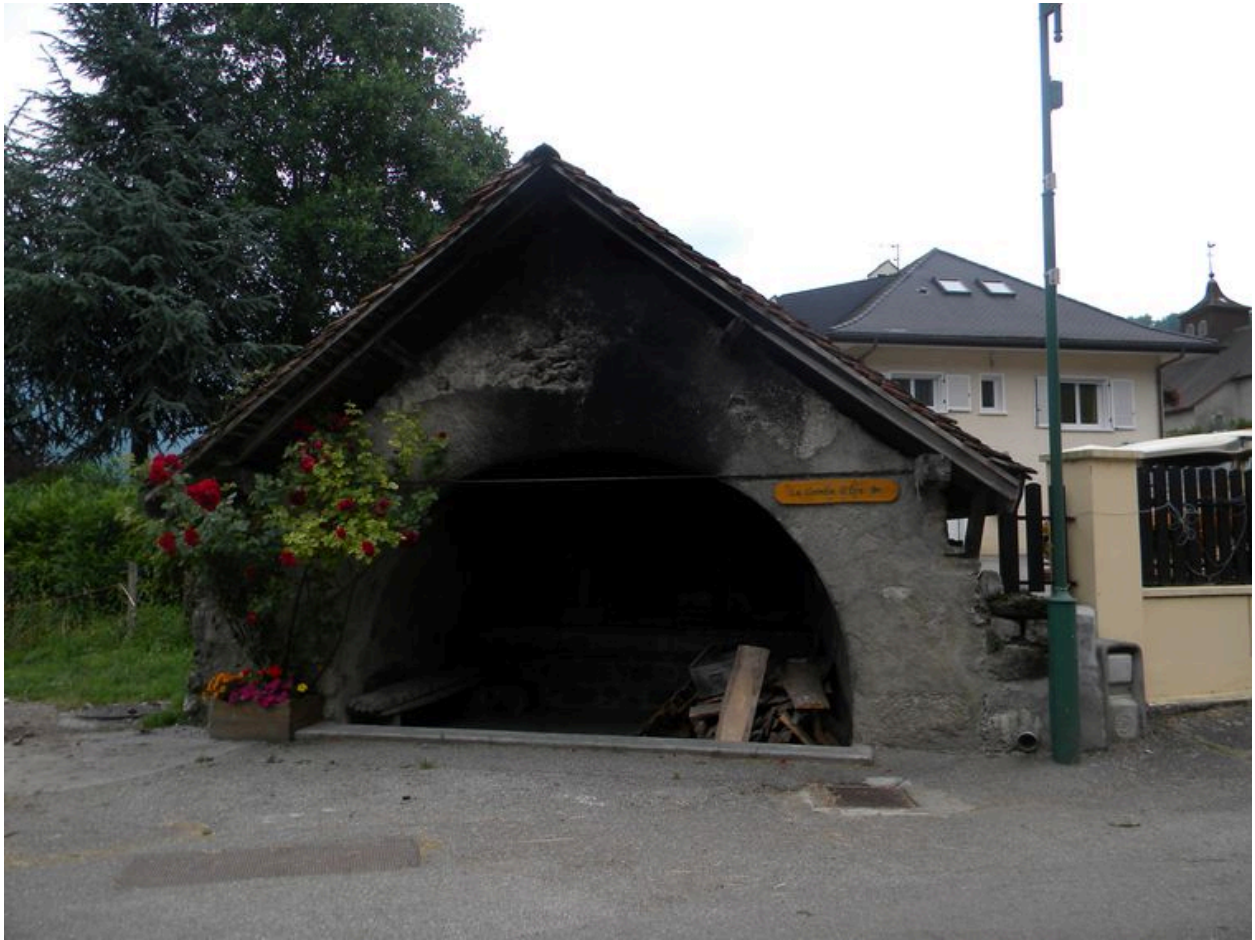
Four avant restauration vue de face.
