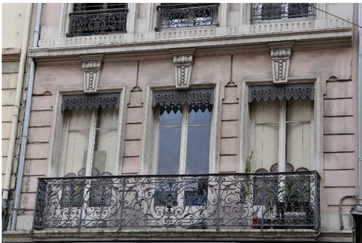
Elévation sur rue : premier étage en entresol
