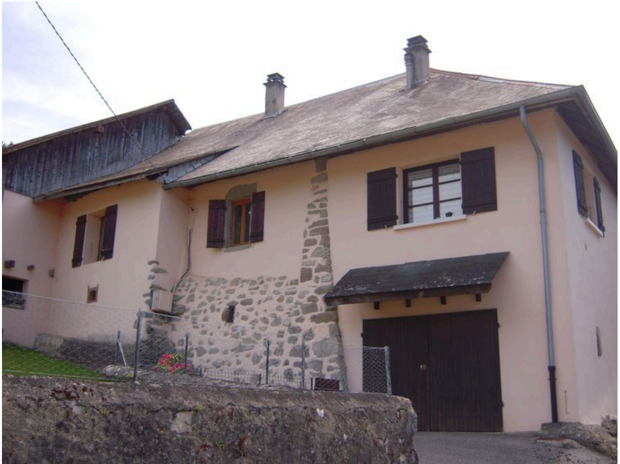
Vue de l'habitation au nord avec une partie ancienne et une neuve.
