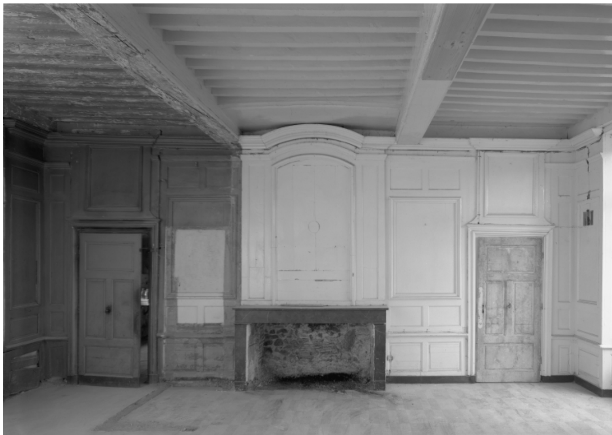
Aile est, vue intérieure de la salle à manger, depuis l'ouest.
