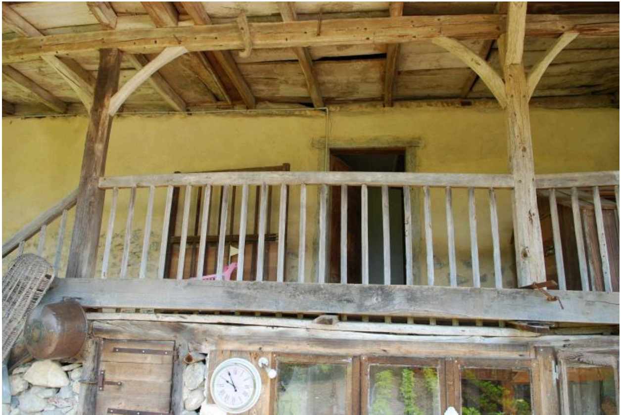
Bâtiment principal, pignon nord-est, détail de la galerie.
