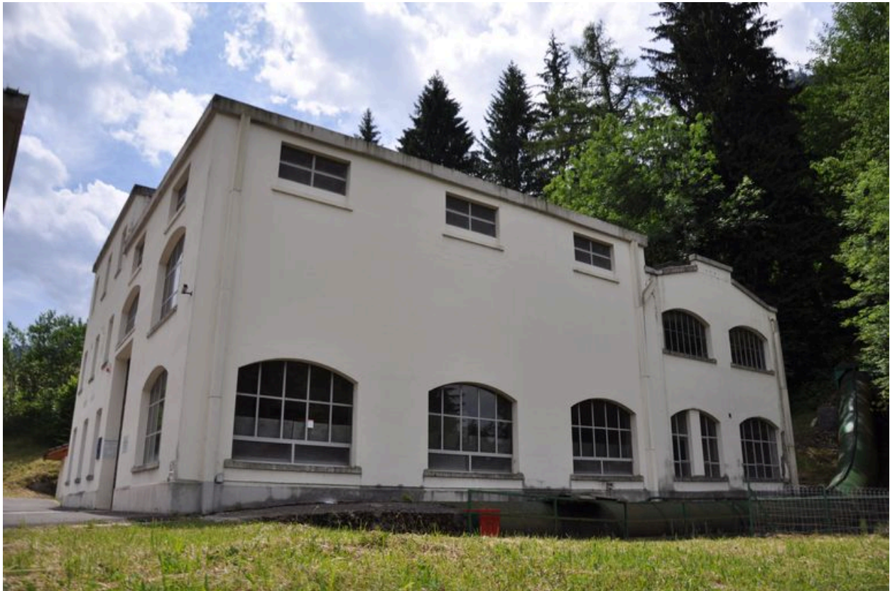
Façade latérale nord
