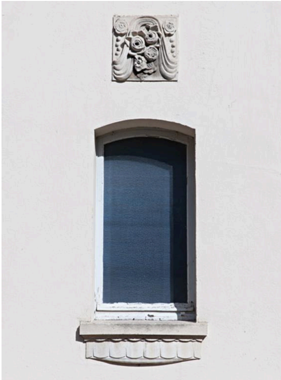
Hôtel-Dieu de Clermont-Ferrand. La polyclinique, façade principale, rez-de-chaussée, baie latérale de l'avant-corps du pavillon nord.
