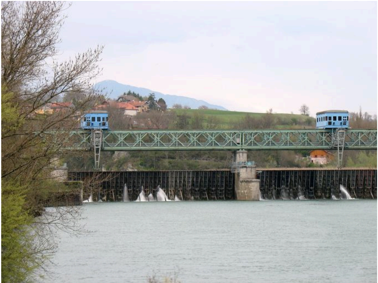
Barrage : vue partielle, face aval (sud)
