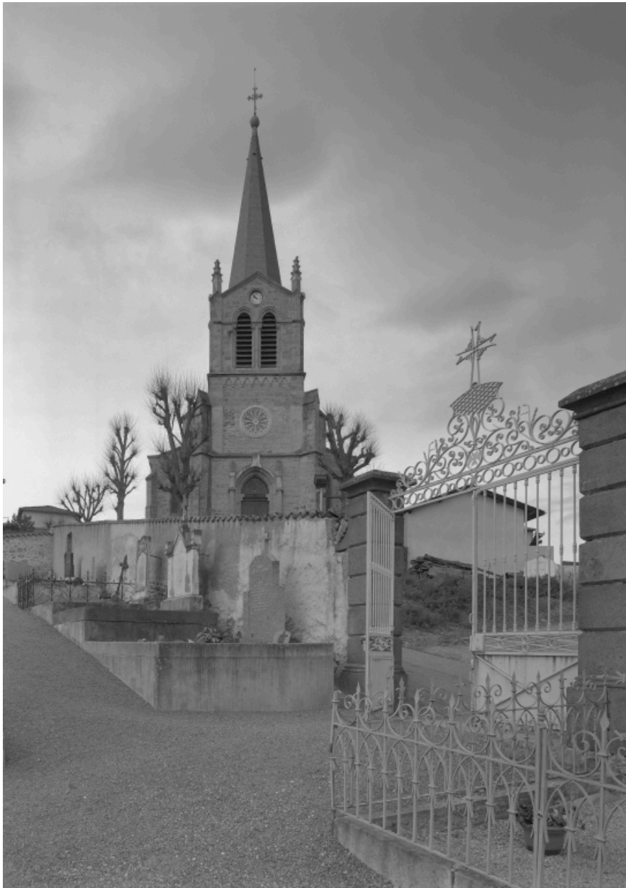
Mur ouest et portail.
