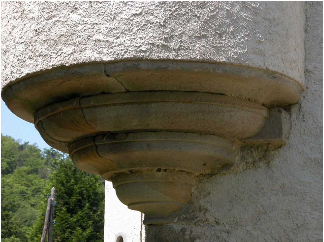
Vue du culot d'une tourelle en surplomb.
