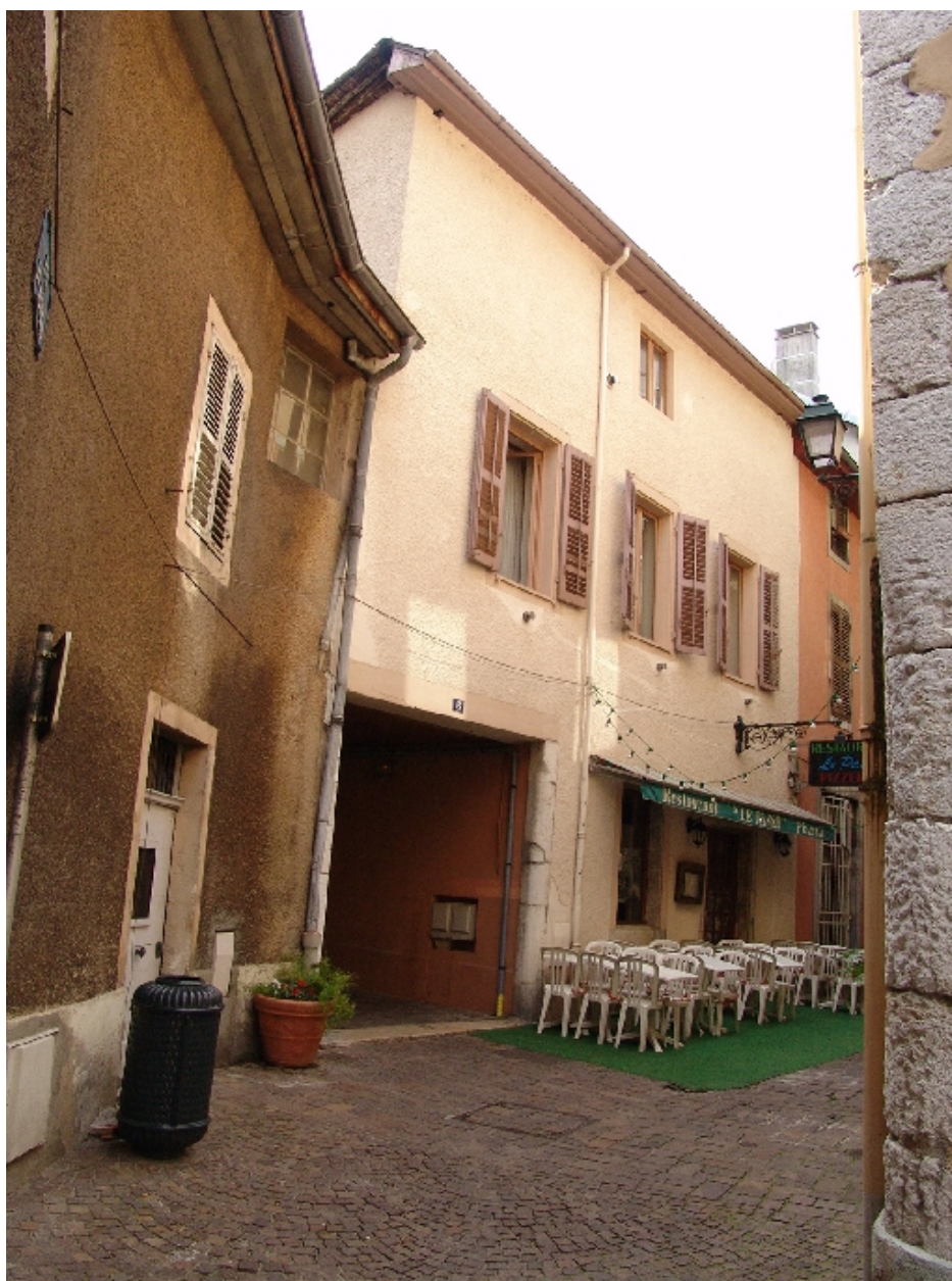
Façade sur la rue du Dauphin
