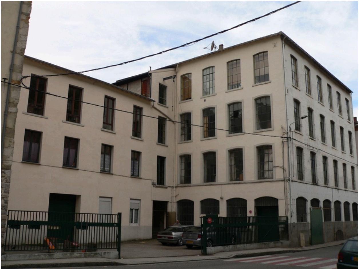
Façade sur rue
