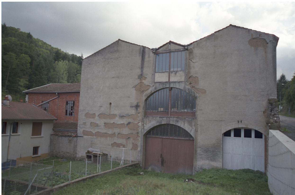
Dépôt des bouteilles, vue d'ensemble de l'élévation latérale droite.
