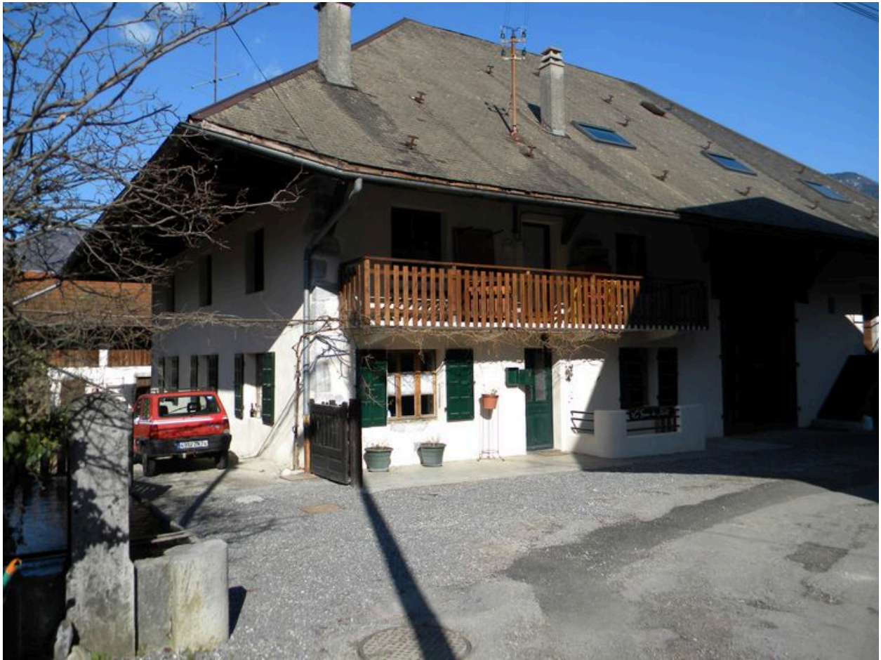
Vue générale de la façade principale.
